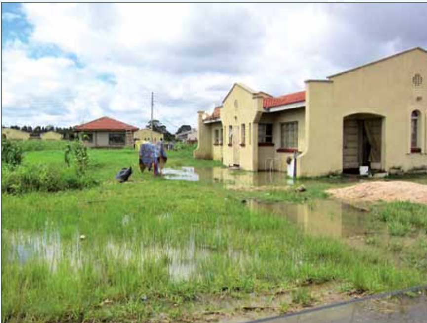
19. Überschwemmungen nach einem Regenschauer
